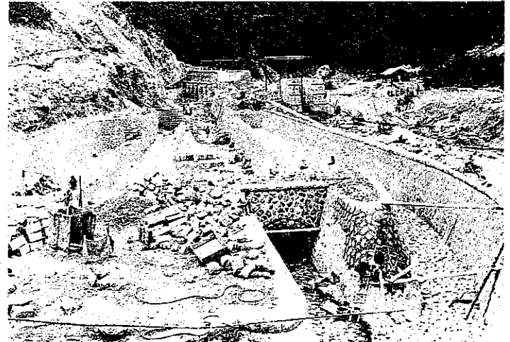
(排砂池尻より上流取入口方面を望む)
