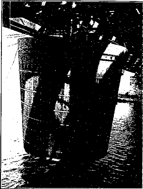
部に据付くべくチェーン・ブロックにて吊上げたる状況 防水用桶内徑上部十呎下部八呎高十呎を舊橋脚井筒頂 寫眞十三
