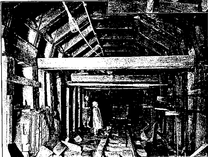
地質軟弱なる部分の支墜工を示す。木材は10吋角なり。
