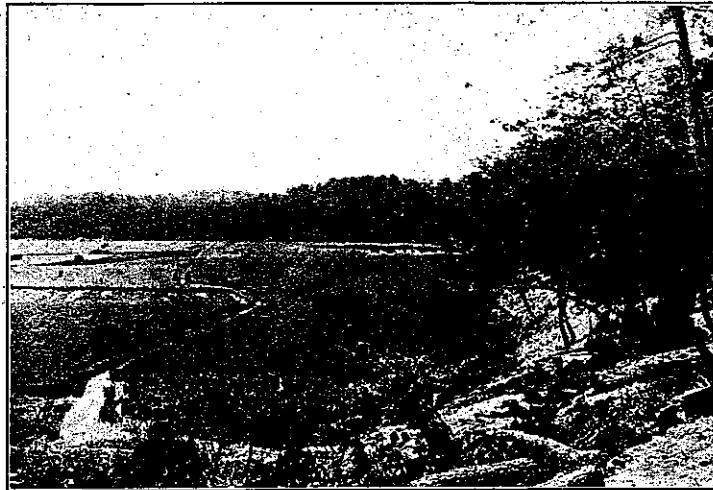
寫真第三 武庫川左岸西大島堤防灣曲部（改修竣功後）
