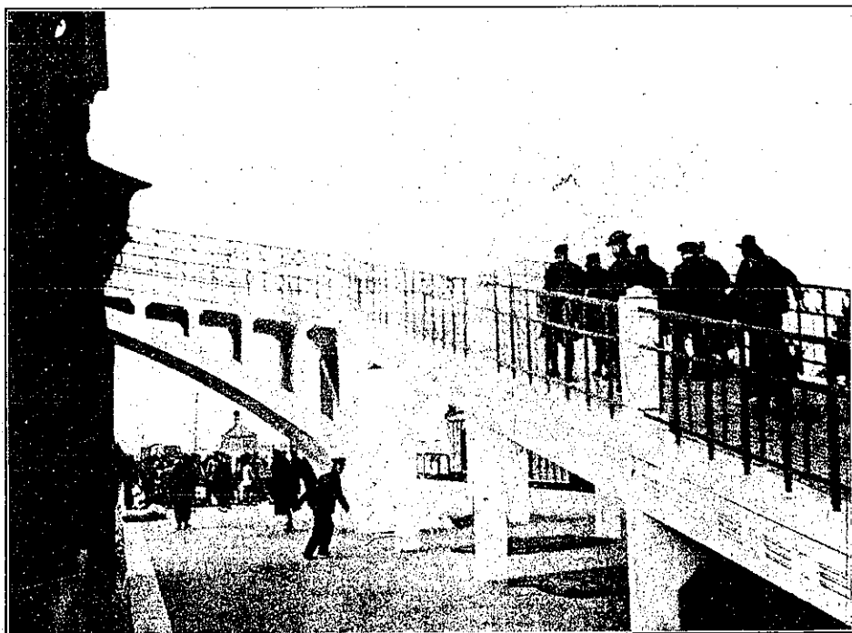
〔寫真第十五〕 津浦線濟南停車場跨線橋
