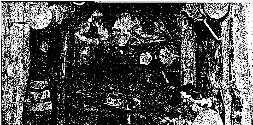
左側本坑掘鑿ノ際支保材せんとる材れ一る等密積セル光景
