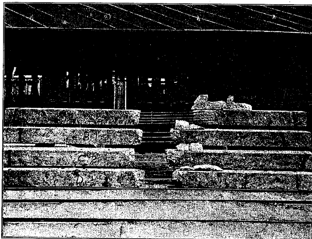
海中桁中央部破壊ノ狀況
