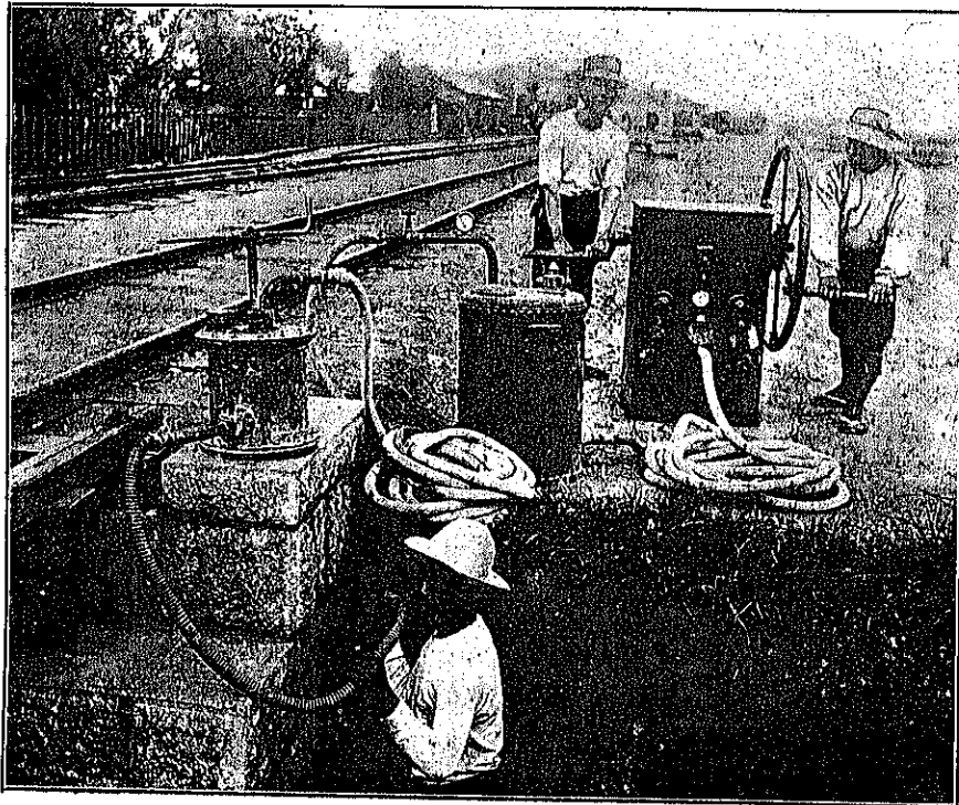
第二圖 膠泥注入器使用ノ實景
