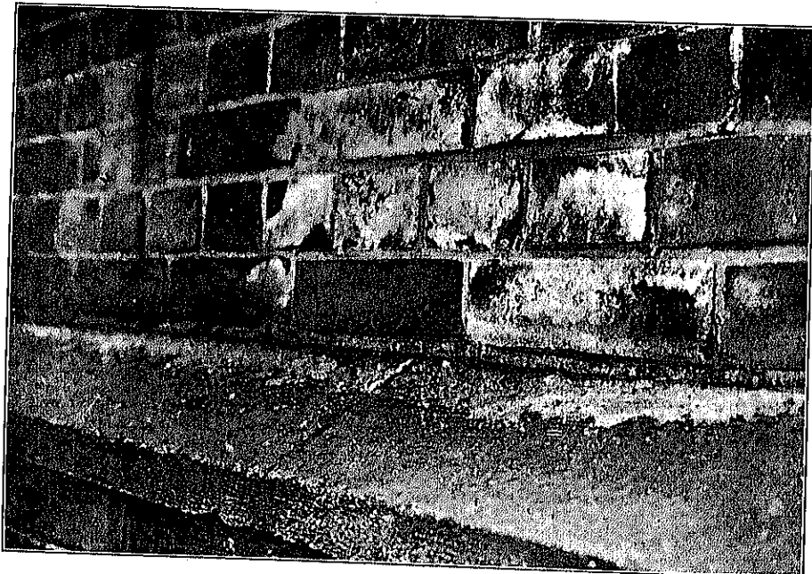
東京高等商業學校東側煉瓦壁 中段ヲナセル石材ニ腐蝕セル所アルヲ示ス
