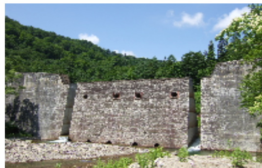
写真-1 大井沢第3ダム(透過型砂防ダム)
