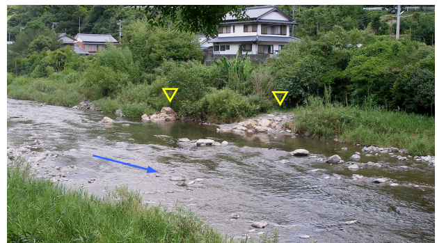
写真-2 完成した2基の水制(▽印)とその前面に創出した淵調になっている。工事後も施工区の上流と同様に、元の瀬の形状や流況は変化していないと判断した。
