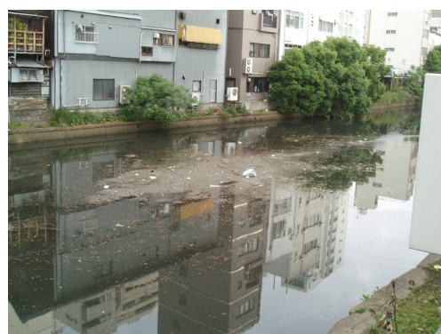
写真-1 浮遊物の塊(伝馬橋)
