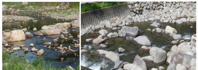
写真-1 石組み落差工の事例
