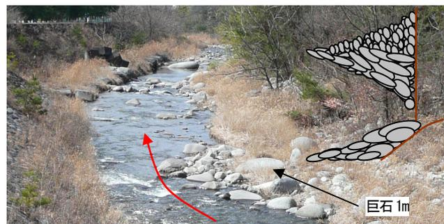
写真-1 笛吹川 琴川合流点直下流の自然形成型水制
