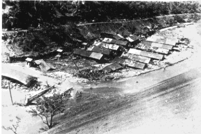
写真-1 被災直後の供給下社宅 (宮田川左岸より撮影) (佐藤, 2001)
