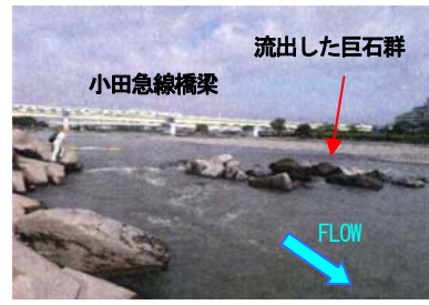
図-1 護床工被災の瞬間(平成19年9月7日6:54頃、左)と巨石護岸の流出(右) 3)
