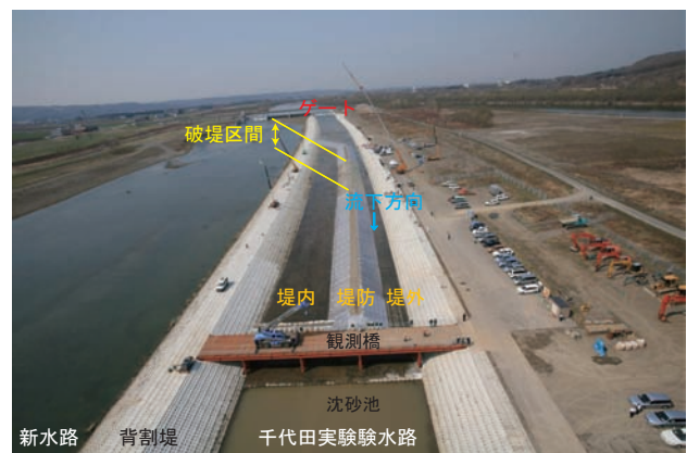
図-1 千代田実験水路内に造成した堤防
