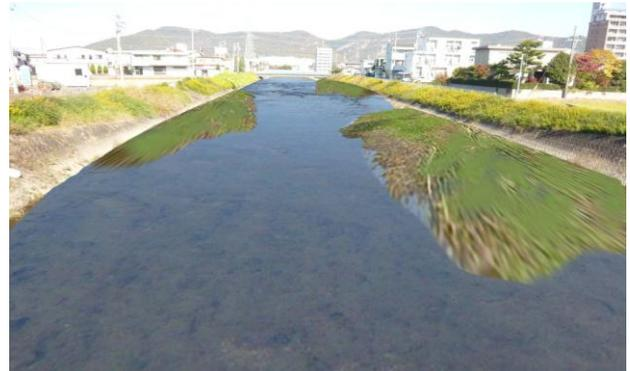
図-7 新堀川に砂州を設置した1k400付近のフォトモンタージュ
