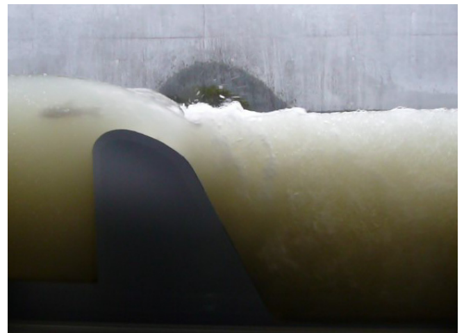
図-1 千代田新水路における階段式魚道の流況
