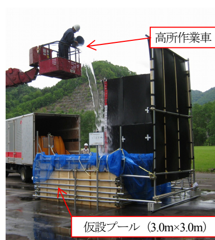
図-2 現地実験の様子
