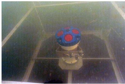
写真-2 ADCP の設置状況写真
