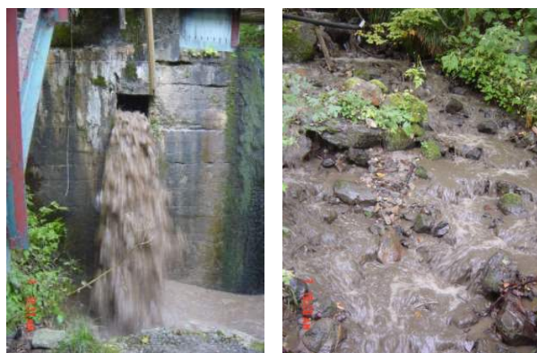
写真-4 試験排砂状況(左: 試験堰堤, 右: 土砂流下状況)
