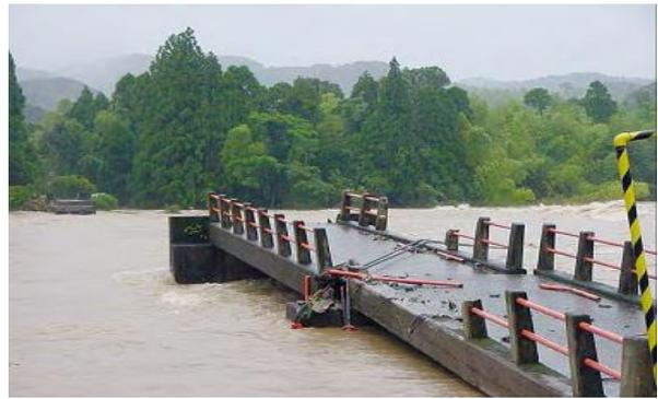
図-6 崩壊した久住橋(広報薩摩川内、第44号より)
