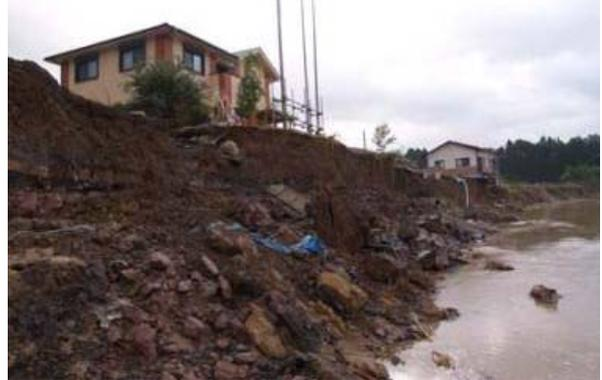
図-7 薩摩川内市五社下地区地先の川内川右岸側の護岸が損壊した(国土交通省の資料より)
