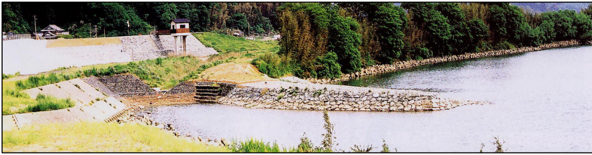
写真-1 肱川河口から18.8kmに位置する不透過水制(ナゲ)
