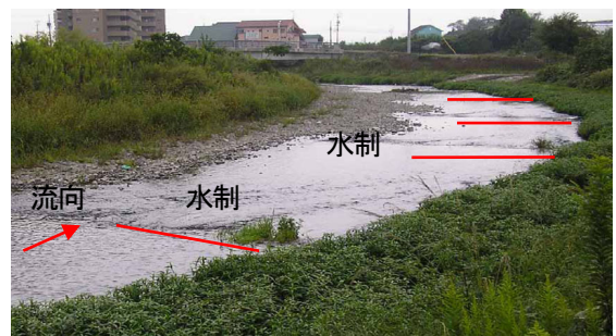
写真-1 湾曲部に石かご水制を連続的に設置した例
