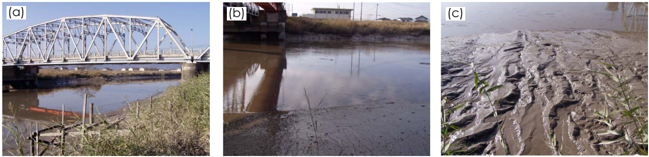
図-1 六角川における粘着性土の堆積状況：(a) 六角橋付近の全景，(b) 採泥場所，(c) 堆積した粘着性土 (国土交通省九州地方整備局武雄河川事務所より提供)
