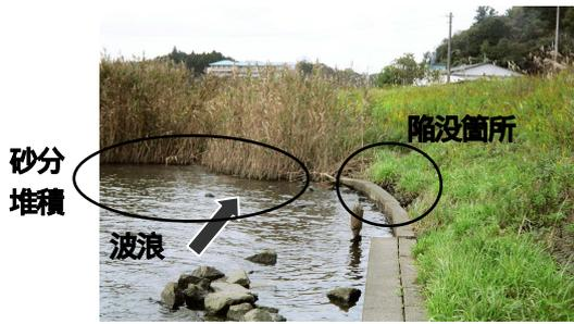
写真-1 湖岸の陥没状況
