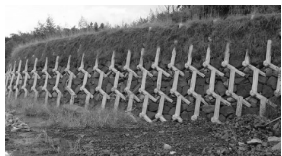
図-2 ブランチブロック工法による法面施工例
