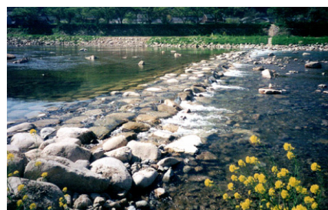
写真-1 連結石礫とその施工例
