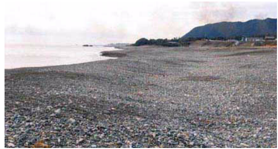
図-5 バームの陸側に形成された斜面（阿田和地区）
