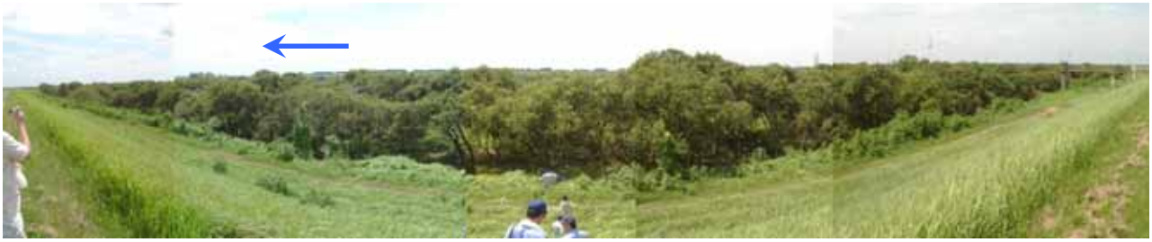
図-2 高水敷一帯に樹木が繁茂している例 利根川左岸123.5km付近 (樹木群透過係数 = 40m/s)
