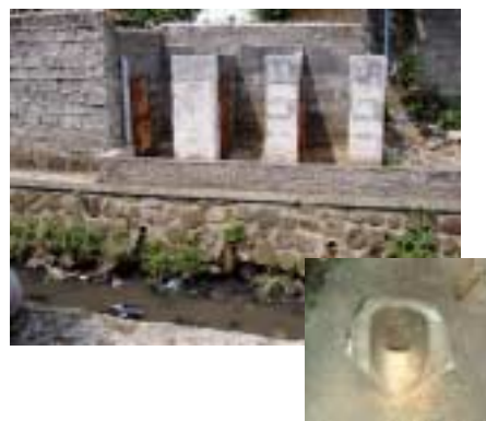
写真-2 共同トイレ
