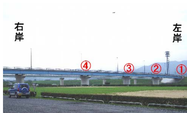
写真-1 葉鹿橋の概観と計測ポイント
