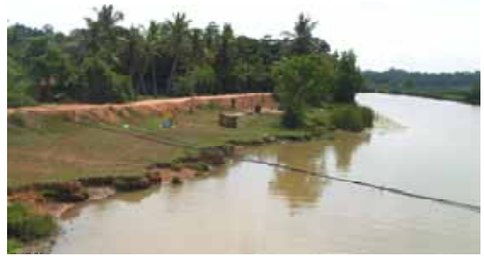
写真-4 河口から9kmの架橋地点から右岸側堤防を望む
