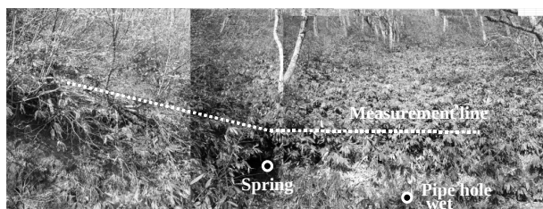
写真-3 蒜山Bの林道切土面の状態
