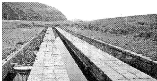
図-2 実験水路(上流から下流を撮影)
