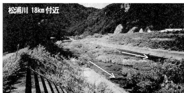
写真-2 松浦川の佐里地区における両岸の護岸と 2 列蛇行流(両岸沿いの流れ)
