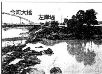
写真-3 刈谷田川左岸破堤部
