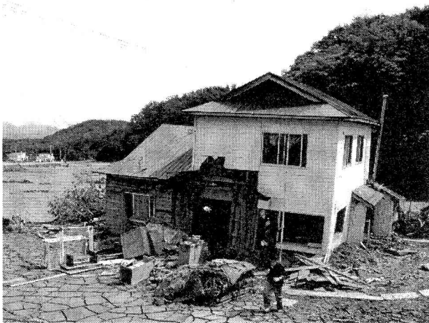
図-2 C地点にある被害を受けた民家
