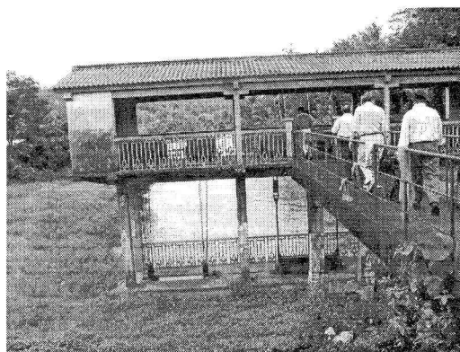
写真－3 内水氾濫対策用のポンプ場
