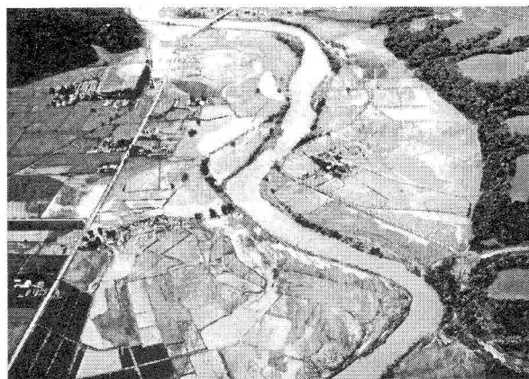
図-6 赤無橋下流（厚別川）の被災状況（北海道提供）
