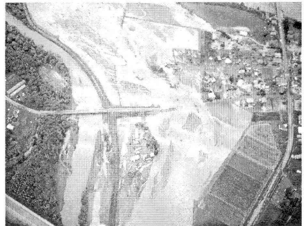
図-2 沙流川上流部(貫気別川コタン橋付近)
