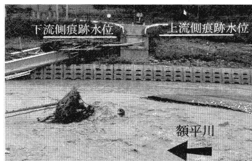
写真-5 アブシ橋の状況
