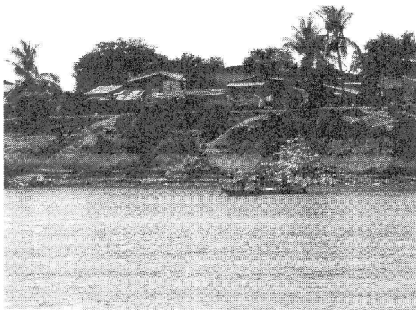
写真-1 プノンペン河岸崩壊
