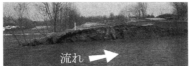
図-8 4月18日流入部左岸側の状況 (SP440 右岸から左岸を望む)
