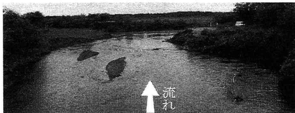
図-13 7月31日流出部の状況 (SP80から下流を望む)
