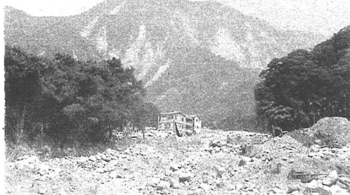
写真－2 南投県水里郷上安村で発生した土石流
