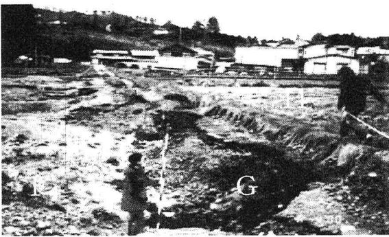
F : 下流側田面 G : 洗掘部 H : 上流側田面 図-7 田面落差による下流側の洗掘状況
