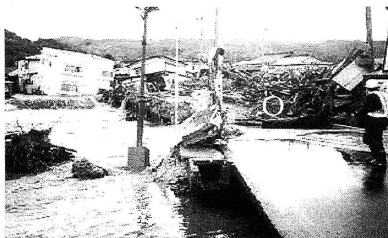
図-11 昭和橋に滞留した流木(O)の状況 1)
