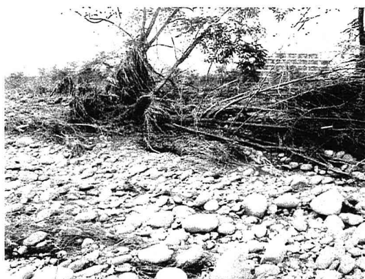
写真-3 洪水後の状況（調査地点1内のA）
