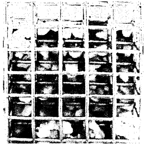
写真-1 格子部分の閉塞状況
