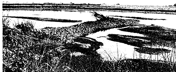
写真－６ 水制杭は流出しているが石が残り 不透過の水制状になっている
