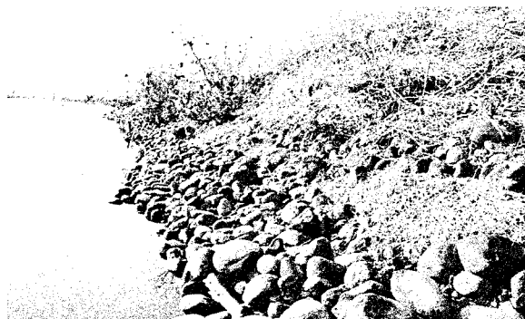
写真－５ 木工沈床が崩壊し捨石状になり 河岸を保護している
