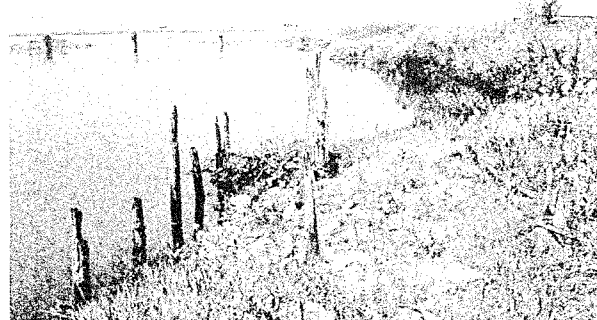
写真－４ 河床低下による水制浮き上がり でも古い水制で守られる河岸
