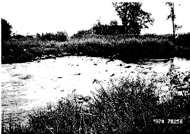
写真-1 ドナウ川の捨石落差工 (Rough Ramp) 1)
